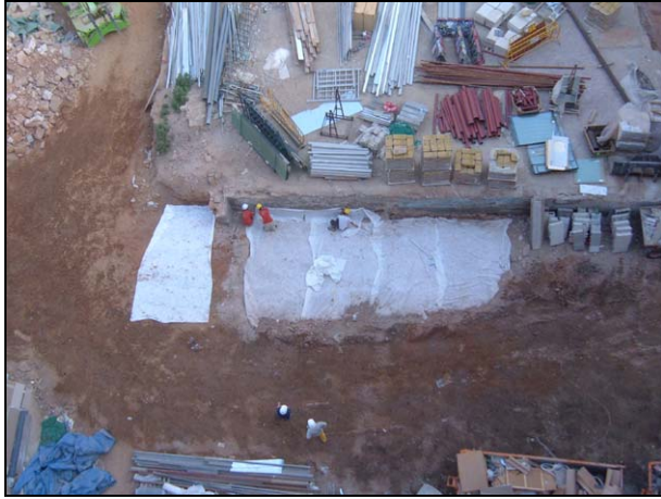
FOTO 32. Sector 1. Protecció amb geotèxtil
