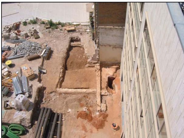
FOTO 98. Sector 2. Vista general del sector, un cop excavat, i arqueta 24.1
