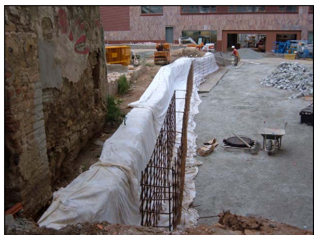
FOTO 135. Sector 8. Incidència del mur 2 sobre les restes documentades
