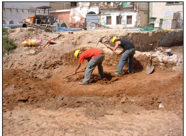
FOTO 4. Sector 1. Excavació àmbit A
