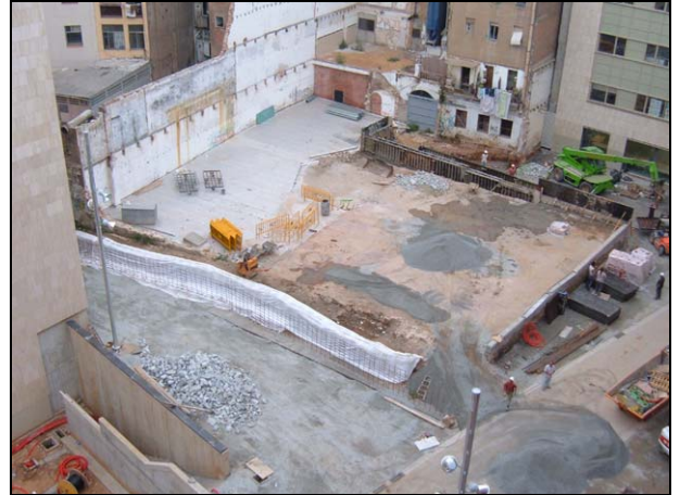
FOTO 137. Sector 8. Vista general de les estructures protegides
