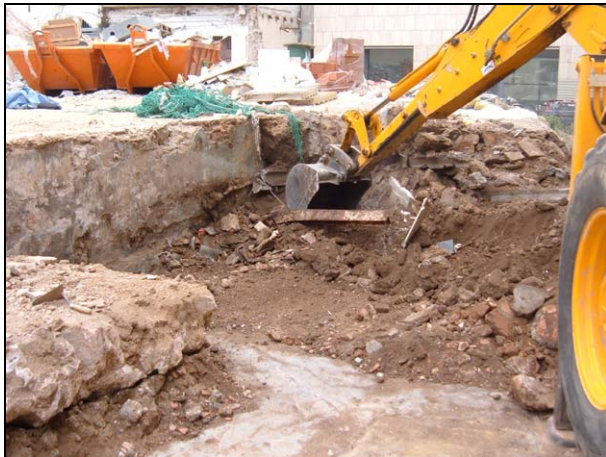
FOTO 15. Sector 1. UE 17. Excavació mecànica
