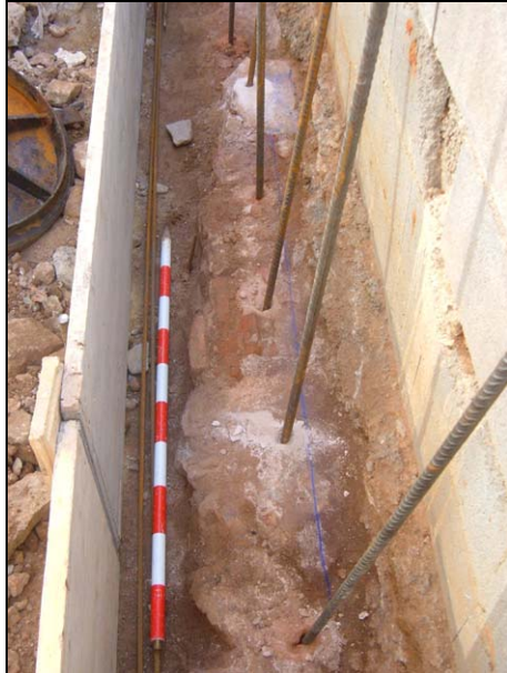
FOTO 124. Sector 5. Mur UE 143
