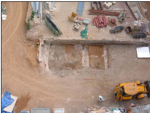
FOTO 3. Sector 1. Vista general de la zona excavada
