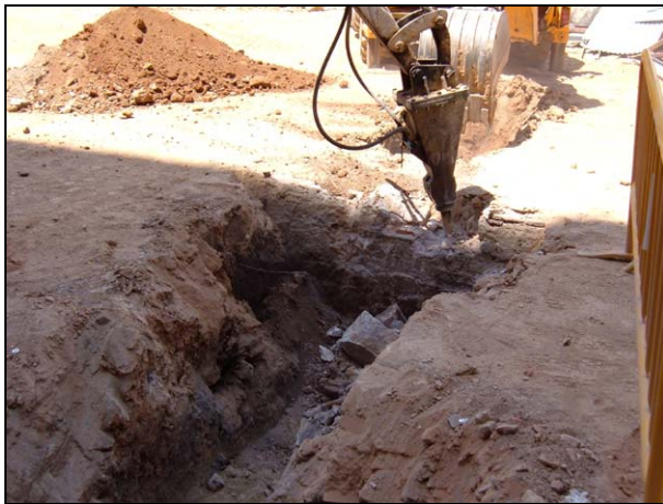
FOTO 26. Sector 1. UE 92. Desmuntatge
